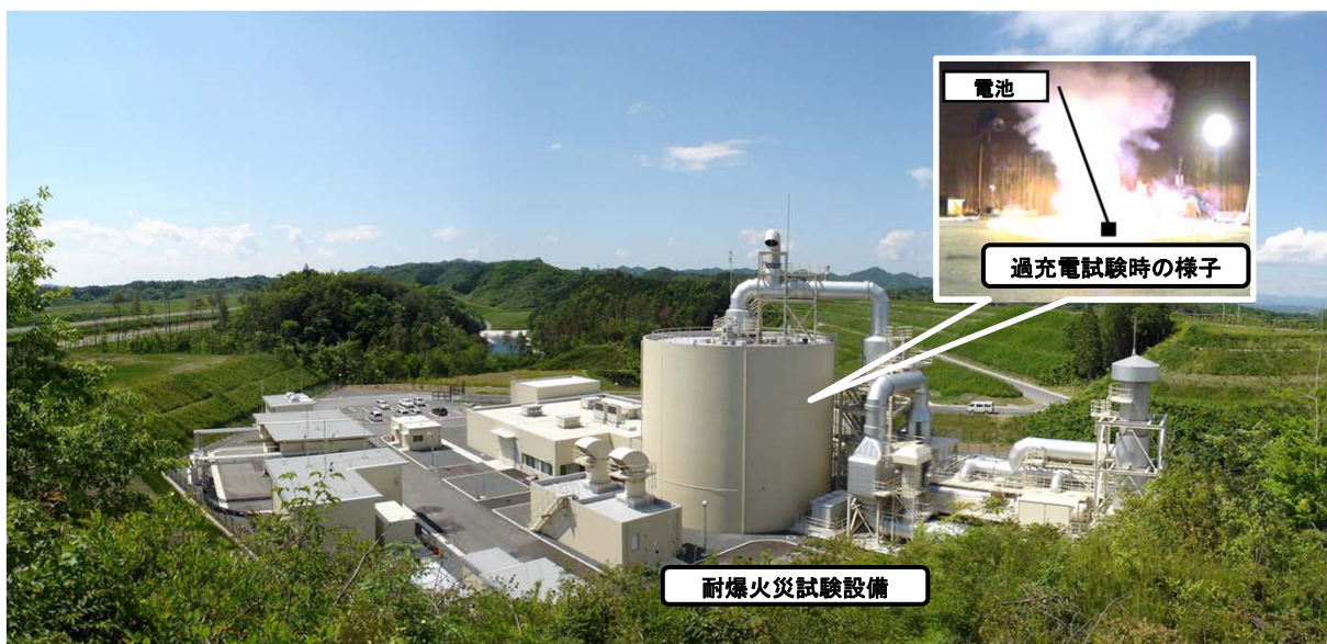
耐爆火災試験設備
